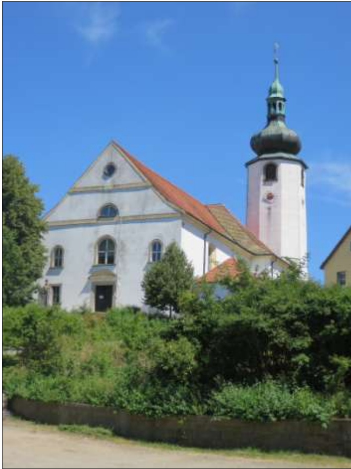
Die Pfarrkirche St. Leonhard von Südwesten
