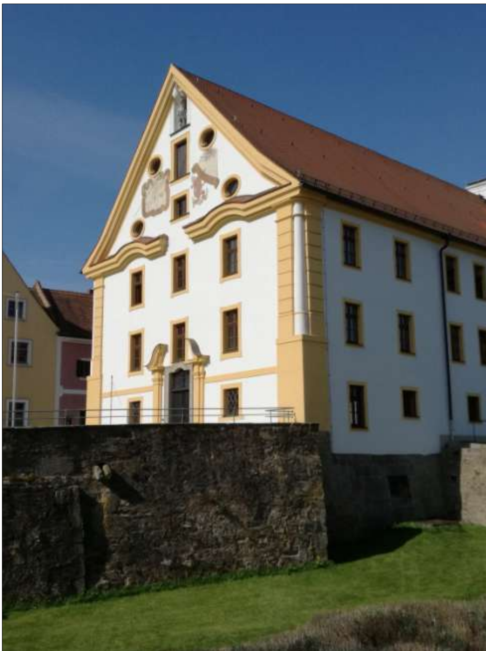
Blick auf die östliche Giebelseite des Kastenamtsgebäudes
