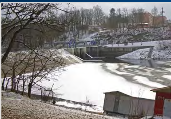
Die Talsperre Skalka (Tschechien) mit Stauwehr
