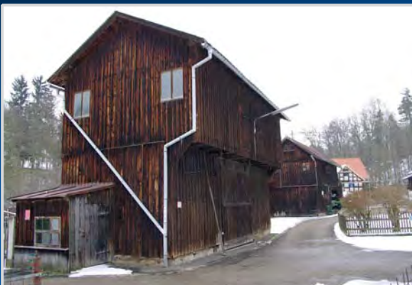
Scheune in Hammermühle
